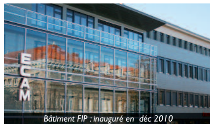
Bâtiment FIP : inauguré en déc 2010
