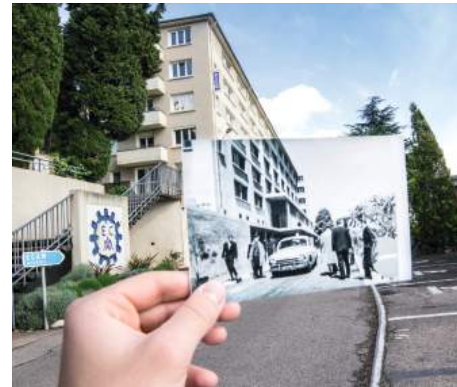
Fin des travaux de la Résidence Jean Bouisset / Mai 1959
